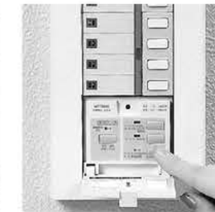
4 初始設定時，請確實按下控制重置 (Reset Controls) 按鈕。(紅色LED亮。)
