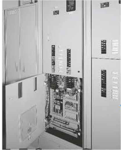
電驛控制盤內部
