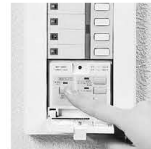
2 按下模式設定 (Mode Set) 按鈕將系統切換至該設定模式。(紅色LED亮)。
